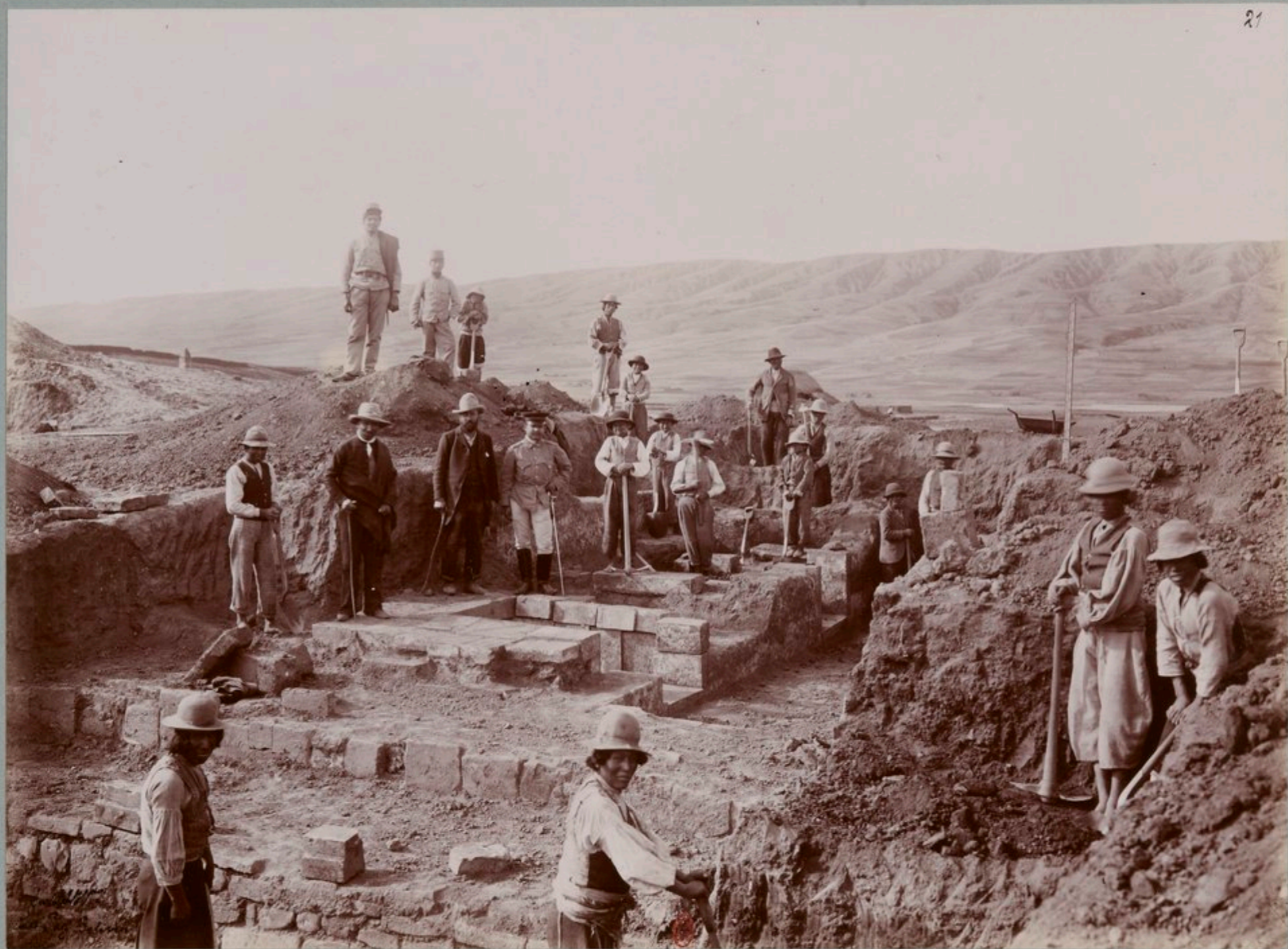
Découvertes de la Mission française. Trois petites salles à l'ouest des grands alignements.
