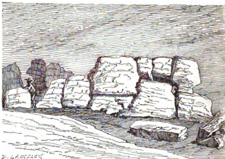
Mur de Manchay, près de Pachacamac.
