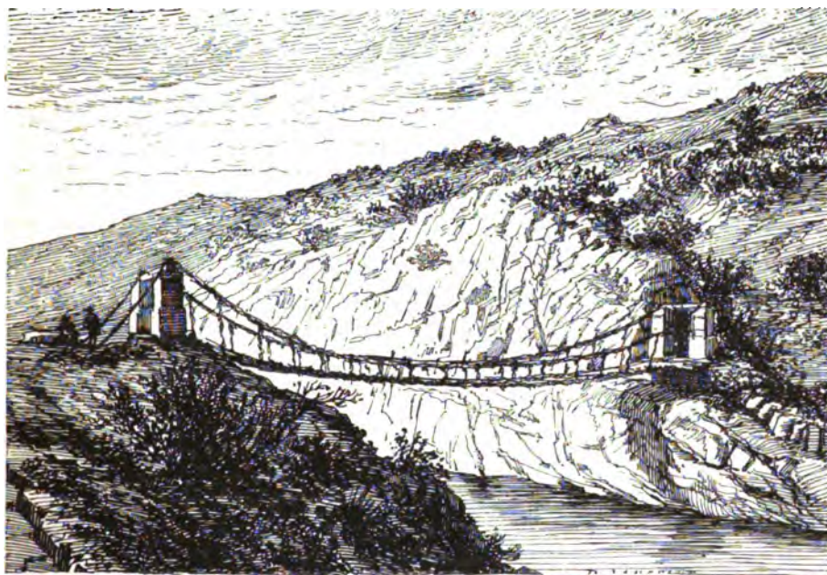
Pont en fibres de maguey sur le rio de Pachachaca.
