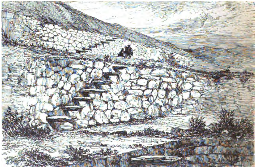
Escaliers dans les andenarias , au nord de Ollantaïtambo (p. 511).
