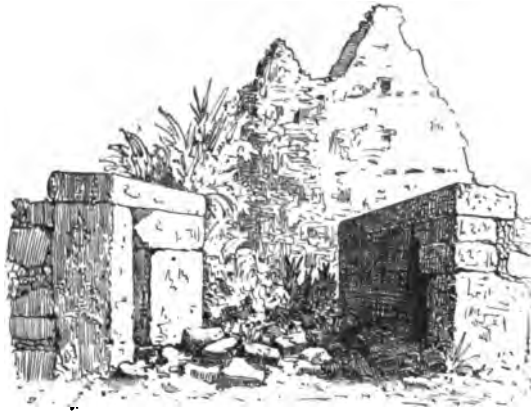
Entrée latérale du Castillo de Marca-Huamachuco.
