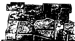
Grand mur cyclopéen dans la ville de Ollantaitambo.
