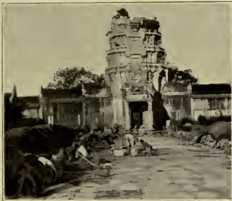
ANGKOR-VAT. — INDIGÈNES TRAVAILLANT A LA RESTAURATION DE LA CHAUSSÉE DALLÉE.
