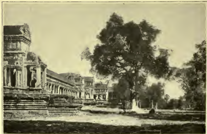
ANGKOR-VAT. — LA TERRASSE DE POURTOUR (PARTIE ORIENTALE).
