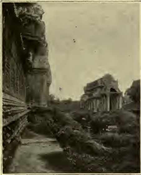
ANGKOR-VAT. — COUR DU PREMIER ÉTAGE : UNE DES BIBLIOTHÈQUES AVANT LES TRAVAUX DE DÉGAGEMENT.
