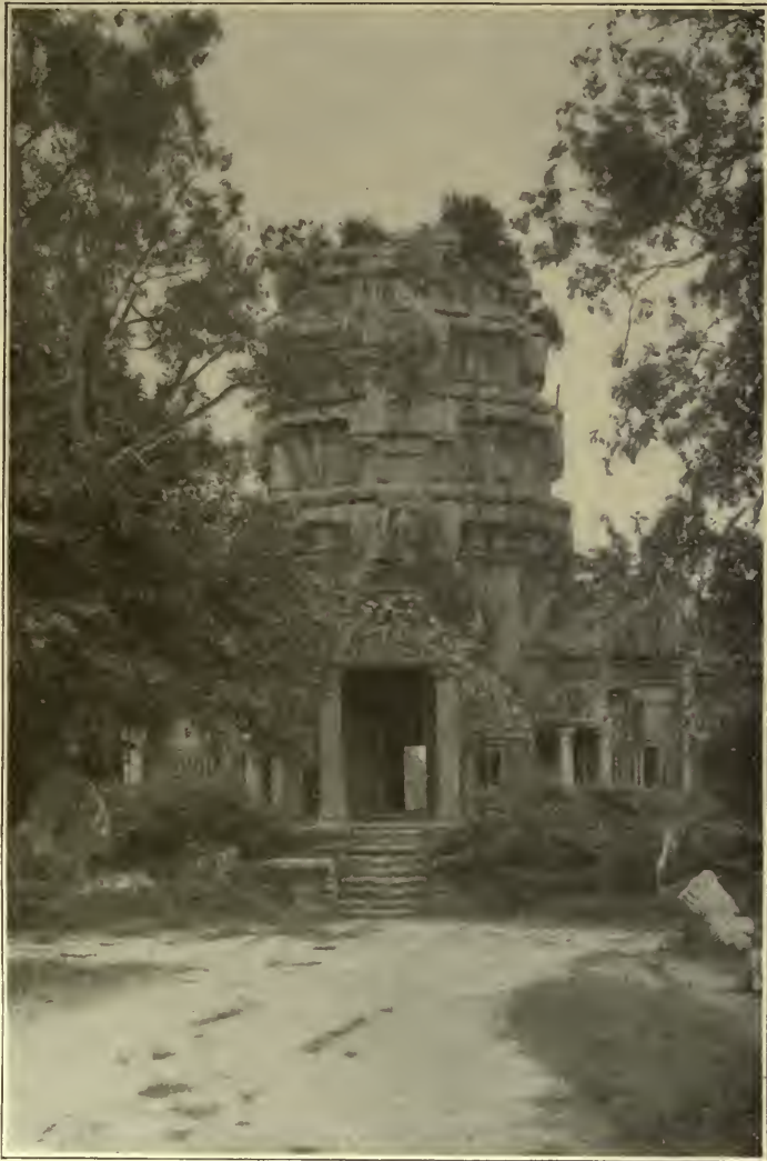
ANGKOR-VAT. — FAÇADE PRINCIPALE DU PORCHE CENTRAL DES ENTRÉES OCCIDENTALES (AVANT LES TRAVAUX DE DÉGAGEMENT.)
