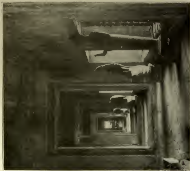
ANGKOR-VAT. — INTÉRIEUR DES VESTIBULES OCCIDENTAUX DE LA GALERIE DU DEUXIÈME ÉTAGE.
