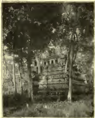
PHIMEANACAS. — LE TEMPLE (VUE D'ENSEMBLE).
