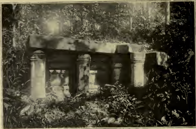
GROUPE DU PHIMEANACAS. — COLONNES SUPPORTANT LA CORNICHE D'UNE TERRASSE CRUCIALE.
